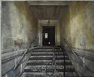
Repräsentativer Zugang zum Gebäude.
