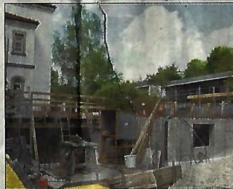
Der Anbau für den Aufzug.
