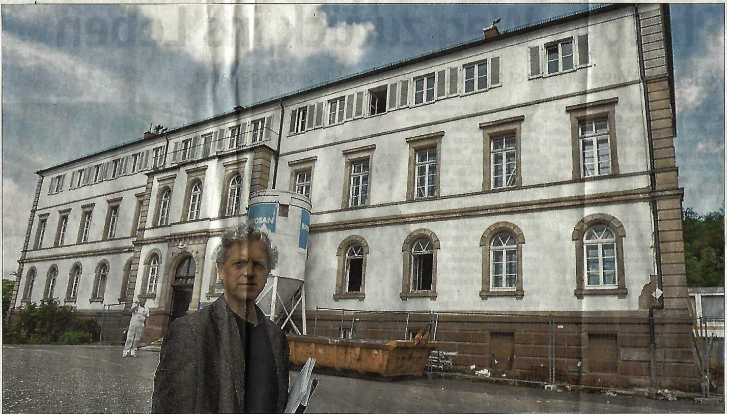
Im September werden die Klosterbergschüler in dieses Gebäude einziehen, Architekt Tilo Nitsche ist mit dem Projekt im Zeitplan.
